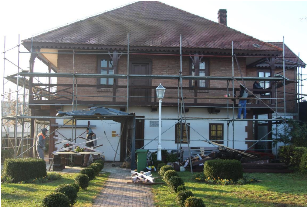
Radovi na zgradi Muzeja u Županji, Čardaku, 2017. godine
