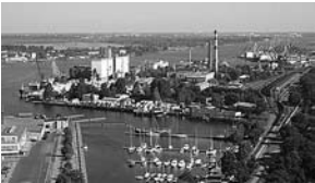
sl. 2.-4. Lokacija budućeg Muzeja suvremene umjetnosti Riga za koji će biti adaptirana zgrada bivše termoelektrane u luci Andrejsala
